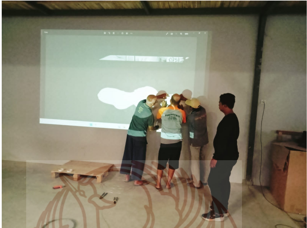
Gambar 11. Proses pembuatan dengan menggunakan bantuan pantulan gambar dari proyektor dengan skala 1:1
