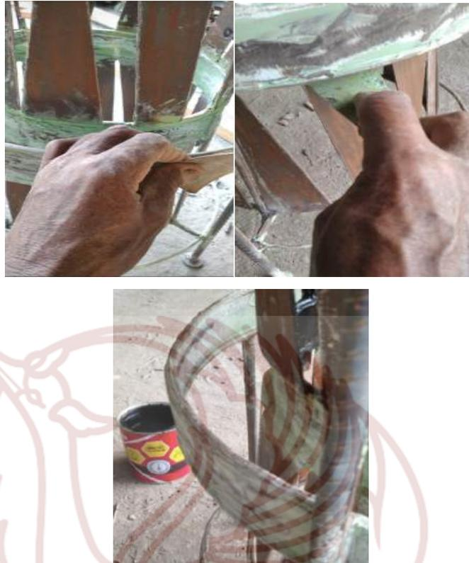
Gambar 11. Proses memperbaiki celah-celah permukaan mempersiapkan top coating
