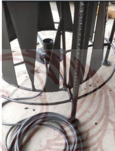
Gambar 14. Pemasangan instalasi listrik untuk outlet kabel sebelum dilakukan top coating
