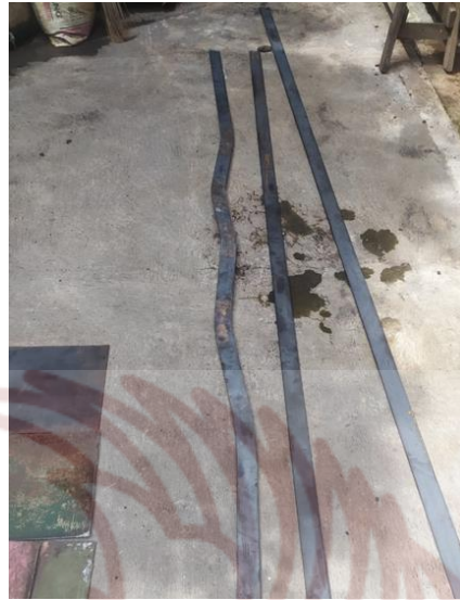
Gambar 3. Besi plat sebagai rangka penguat konstruksi (Foto : Bening Tri Suwasono, 2022)
