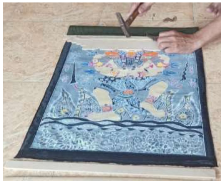
Gb.47. Pemberian frame kayu bagian atas dan bawah agar kuat dibantu perekat lim kayu, dipasang yang tepat dan dipaku dari belakangnya.
