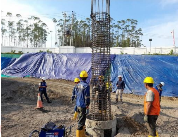
Gambar 66. Monitoring Pemasangan Besi Tulangan (Foto : Fabianty Edgar, 2023)
