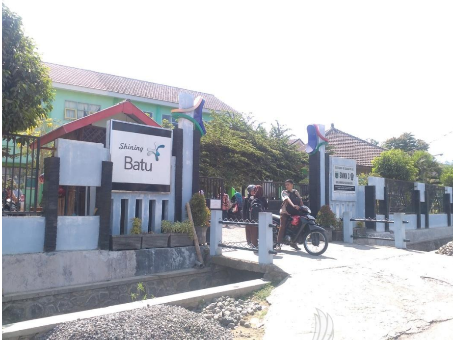
Gambar 7: Gedung SMKN 3 Batu
