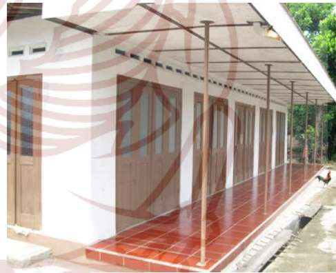
Gambar 10: Gebyog sudah direduksi menjadi pintu lempit yang digabungkan dengan tembok (Foto: Budiwiyanto, 2016)
