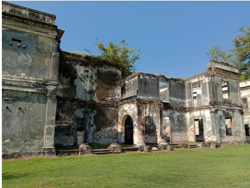
Bekas Gudang Penyimpanan Komoditas Dagang
