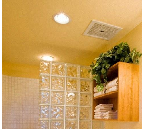
Gambar 112. Aplikasi ceiling mount exhaust fan dalam kamar mandi
