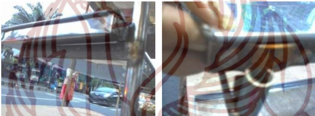
Gambar 17. Rangka Stand Produk makanan Ngarsopuro sudah ada kerusakan pada hanging (gantungan) rak sehingga diganti dengan system penopang besi (Dok. Tati W, 27/06/2016)
