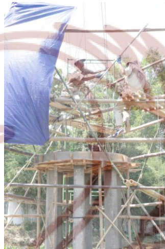
Gambar 17. Pembuatan patung dengan kontruksi besi beton Foto Amir Gozali 2016.
