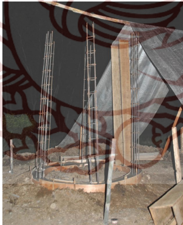
Gambar 13. Pengecoran tiang pustek dengan kontruksi besi beton, Foto Amir Gozali 2016.
