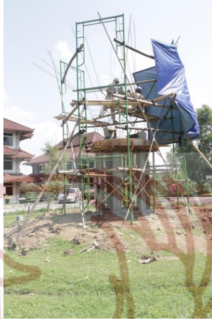
Gambar 15. Pembuatan kerangka patung dengan konstruksi besi beton, Foto Amir Gozali 2016.
